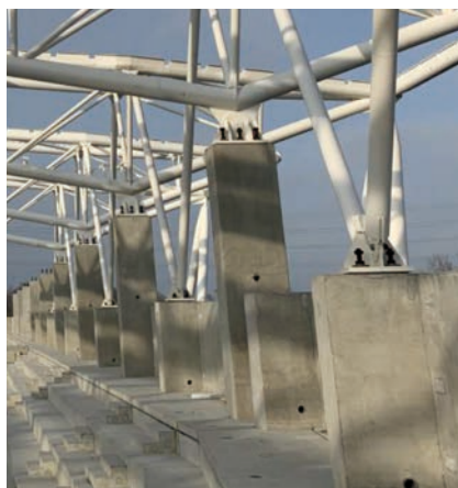
Fot. Stalowa konstrukcja dachu stadionu zamocowana z wykorzystaniem systemu PGS PFEIFER
