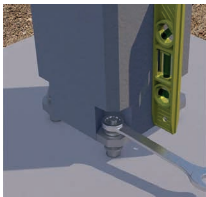
Rys. 1. Rektyfikacja i zalewanie zaprawą słupa prefabrykowanego
